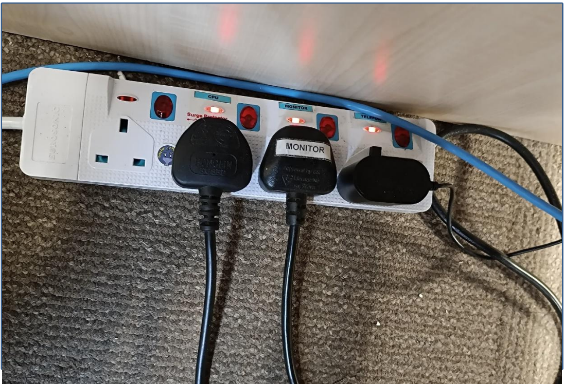
Penemuan Komponen B6 ( Pelabelan ):Pelabelan tidak di tampal di atas kepala soket. Pic: Mohamad Zairiq Zainal bin Abdullah
